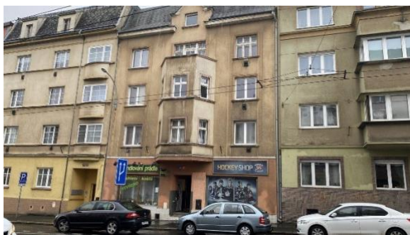
Celkový pohled na bytový dům
